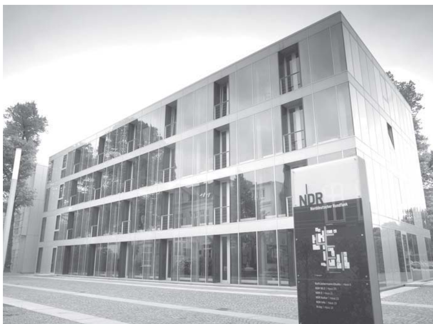
Das neue digitale Hörfunkgebäude des NDR, das 2007 fertiggestellt worden ist
